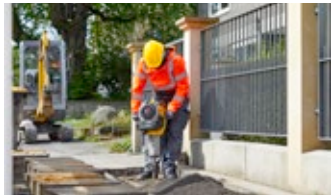
Tecnología de demolición y corte
